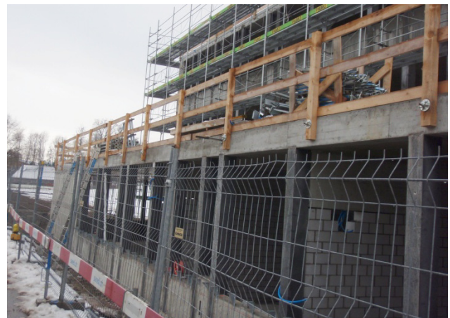
1 Korrekter dreiteiliger Seitenschutz gemäss SN EN 13374
